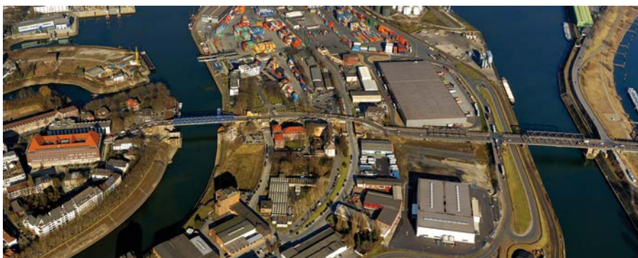
Bild 3. Übersicht Baustellenanbindung von Süden Fig. 3. Overview on the access of the southern construction site
