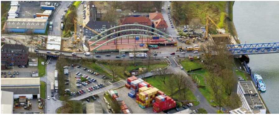
Bild 8. Übersicht Montagefläche Fig. 8. Overview of the assembly area
