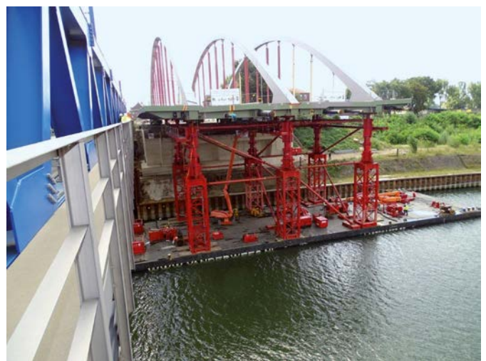
Bild 12. Einschub der neuen Brücke – Lastübernahme durch Ponton Fig. 12. Positioning of the new bridge, support with pontoon
