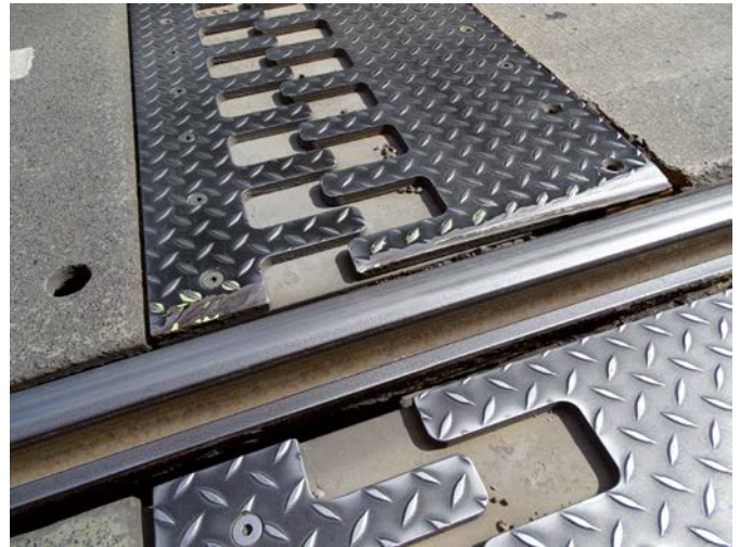
Bild 10. Fingerübergang Behelfsbrücke Fig. 10. Expansion joint of the temporary bridge
