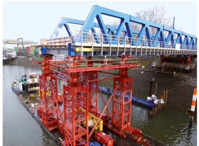
Bild 11. Einschub der Behelfsbrücke Fig. 11. Positioning of the temporary bridge
