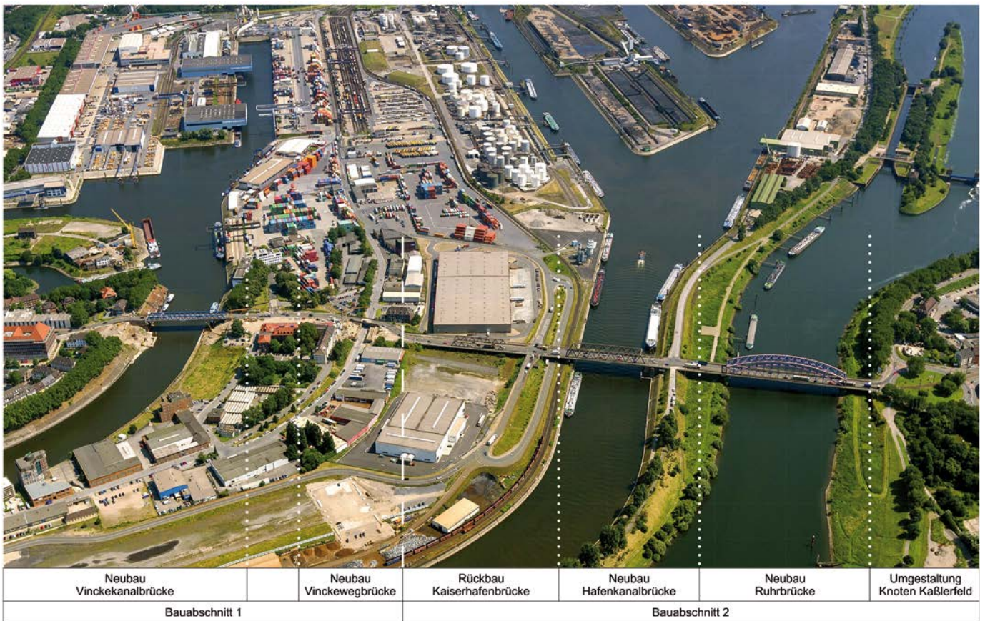
Bild 2. Gesamtübersicht Bauabschnitte 1 und 2 Fig. 2. Overview on the construction phases 1 and 2
