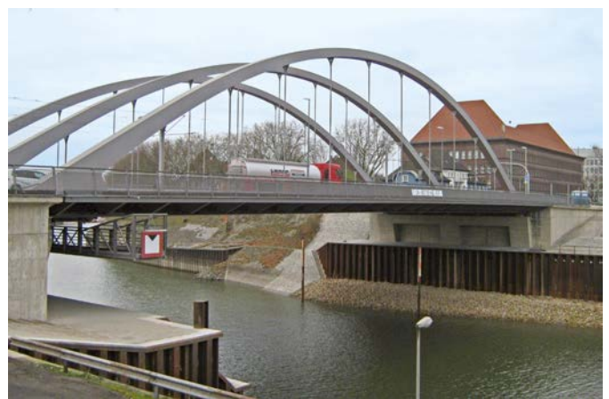
Bild 14. Fertige Brücke, Blick von Süd-Osten
